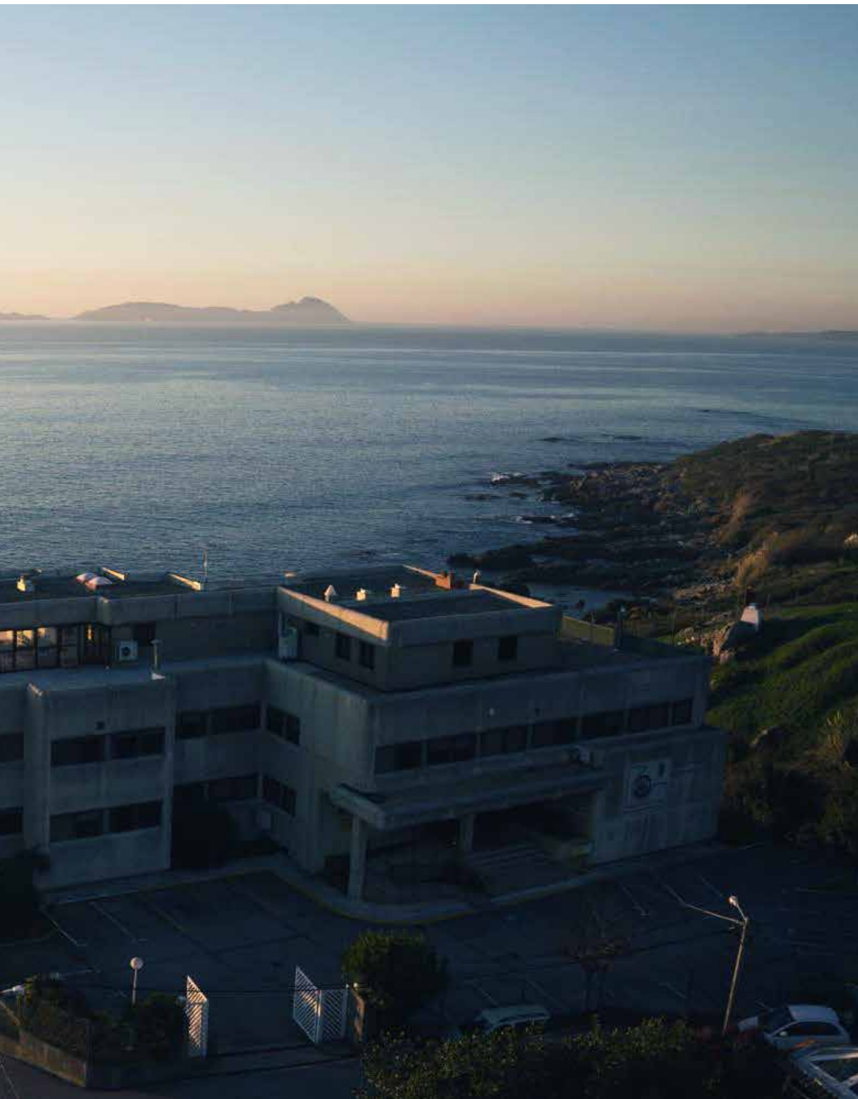
Instalaciones del Centro Oceanográfico de Vigo (COV) en Cabo Estai. A la derecha, el edificio principal; a la izquierda, la Planta de Cultivos.
