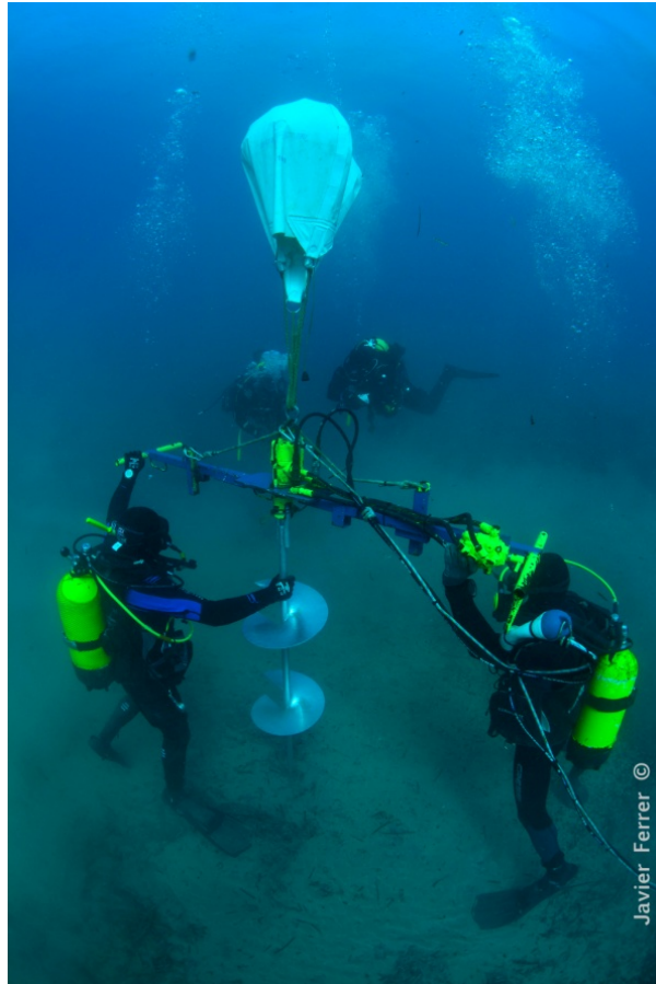
Instalación de un fondeo de bajo impacto. Fotografía: Javier Ferrer
