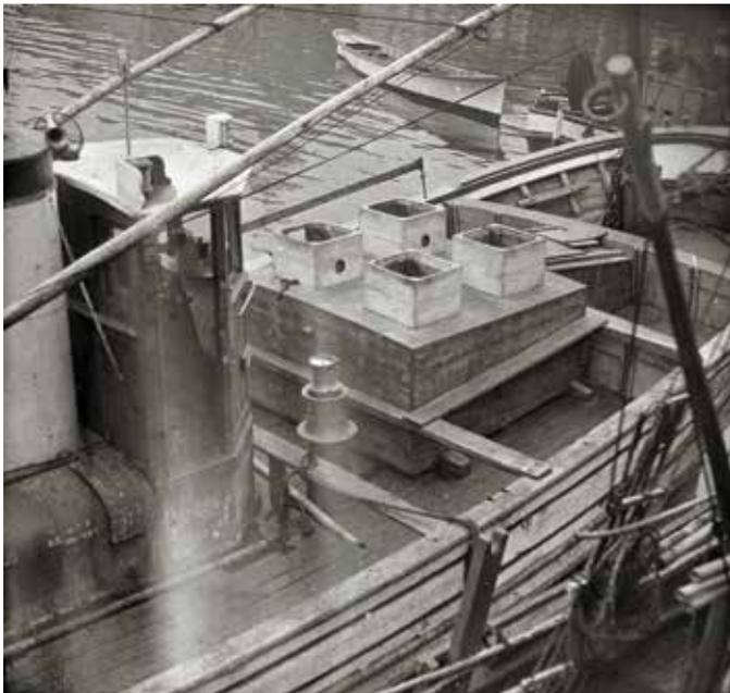
Primitivas cubas (foto superior) y tanques de cebo vivo montados sobre la cubierta (foto inferior) usados en los barcos atuneros de Gipuzkoa en 1948, año de la introducción de este nuevo sistema de pesca. Fotografías de José María Navaz, cortesía de la SOG.
