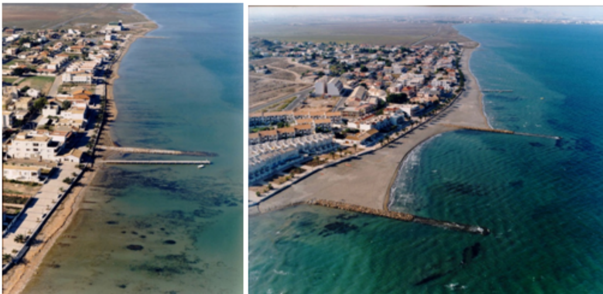
Figura 4.8: Izquierda: imagen de la playa original de Los Urrutias. Derecha: aspecto de la playa tras la construcción de los espigones y el aporte de arena. Fuente: Demarcación de Costas de Murcia.
