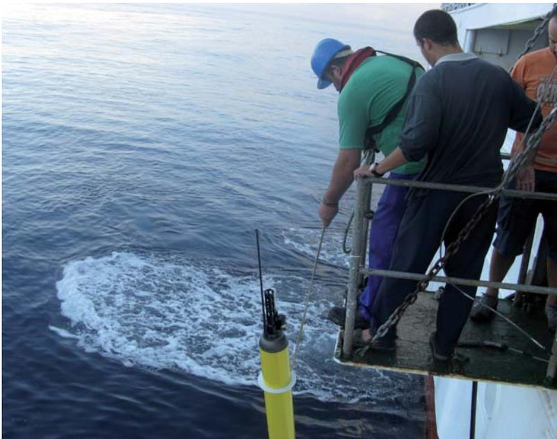
Figura 6: Lanzamiento de boya Argo a bordo del Barco Oceanográfico Cornide de Saavedra.
